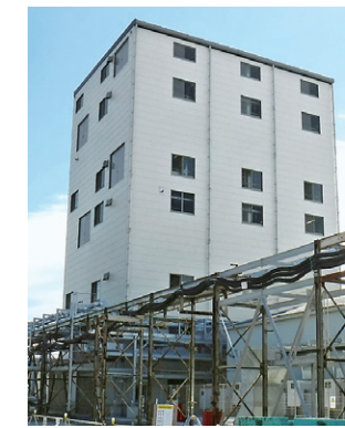
新設中のプラント
